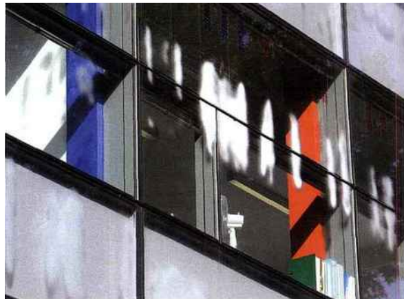
▲ Pose en face 1, la sérigraphie contribue à faire oublier les joints de collage noirs du Vec, en face 2
