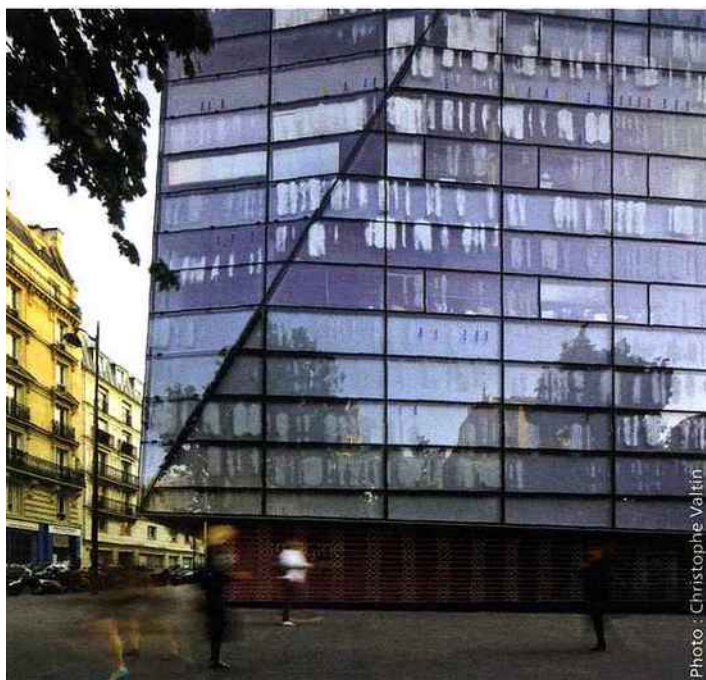
▲ Double vitrage faiblement émissif, avec contrôle solaire et store intérieur, pour les étages à l'abri du soleil.
