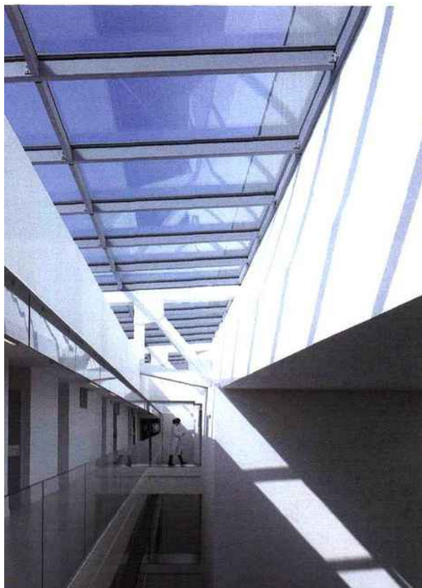
▲ Sur les façades ensoleillées, le vitrage respirant se compose d'un simple vitrage Vec extérieur sérigraphié avec store intégré, et d'un double vitrage faiblement émissif en face intérieure
