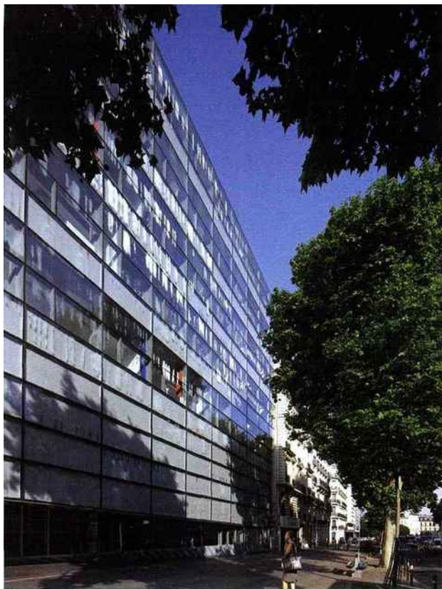
▲ Sur les façades ensoleillées, le vitrage respirant se compose d'un simple vitrage Vec extérieur sérigraphié avec store intégré, et d'un double vitrage faiblement émissif en face intérieure
