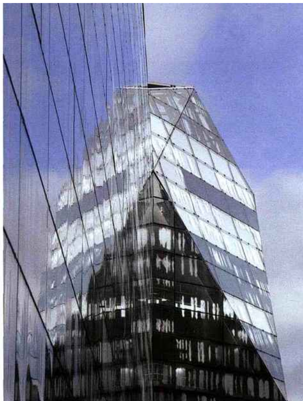
▲ ▼ Une volumétrie complexe où le vertical côtoie les plans peu à fortement inclinés, soit des réglementations différentes pour les systèmes vitrés mis en œuvre
